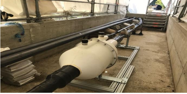
Şekil 31. 420 kV 2500 mm2 PQ devresi izole ek montajı
